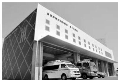
板野東部消防組合 庁舎改築事業 (平成22年度長期貸付)
